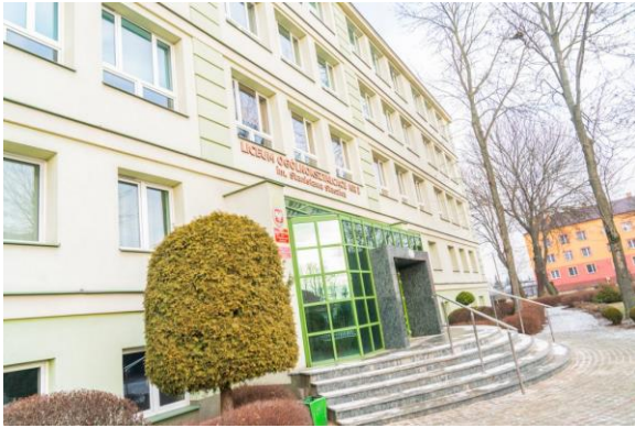
Zdjęcie budynku szkoły
