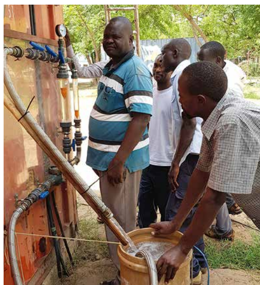
▲ ŠTUDENTI VZDELÁVACIEHO EKOLOGICKÉHO CENTRA SV. PETRA CLAVERA VYTIHLI ČERPADLO ZO STUDNE HLBOKEJ STO METROV. SNAŽIA SA PRÍŠŤ NA TO, ČI JE PRÍČINOU PROBLÉMU ČERPADLO, UPCHATÉ POTRUBIE ALEBO CHYBNÉ SOLÁRNE PANELE. SNÍMKA: ARCHÍV BBM, 2018
